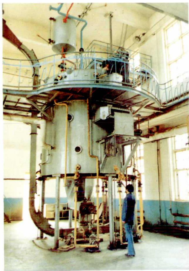
门源县粮油加工厂浸出车间
