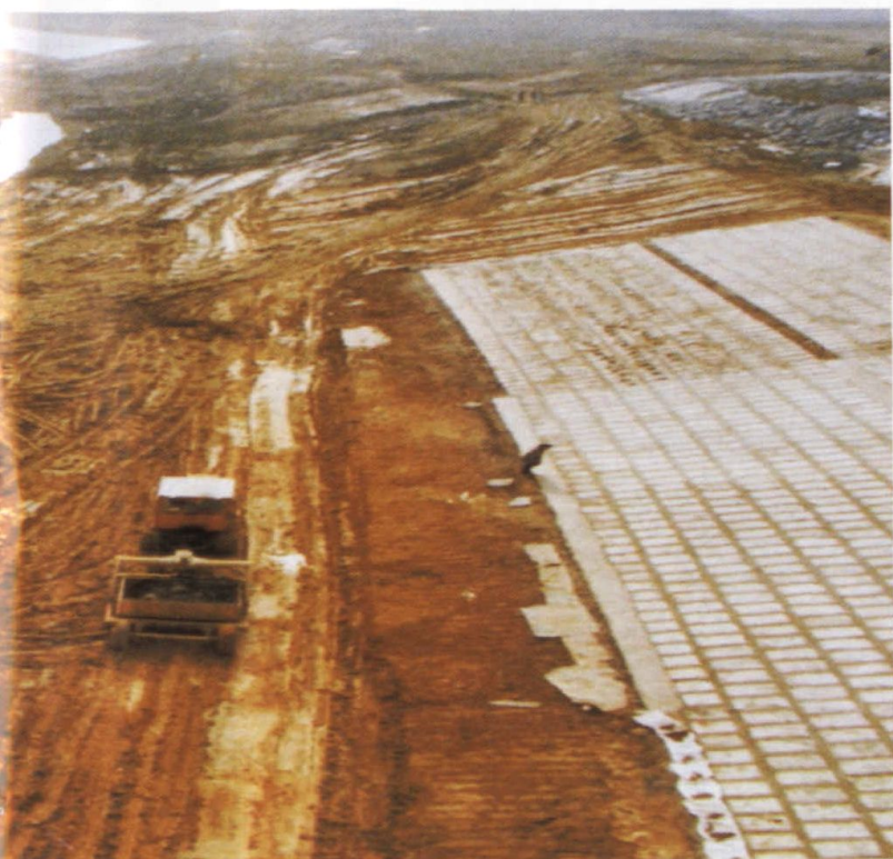
镇江越河口段 断航施工
