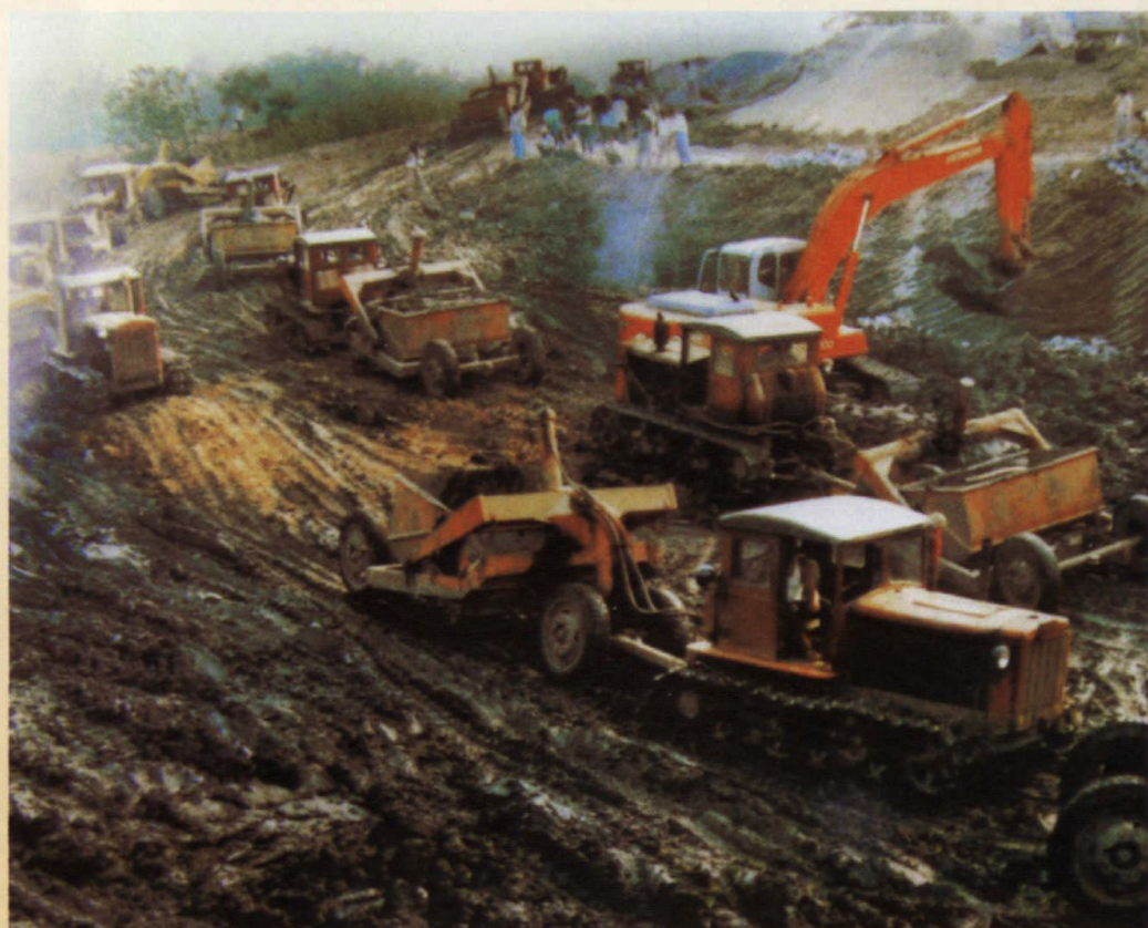
镇江辛丰段断航施工
