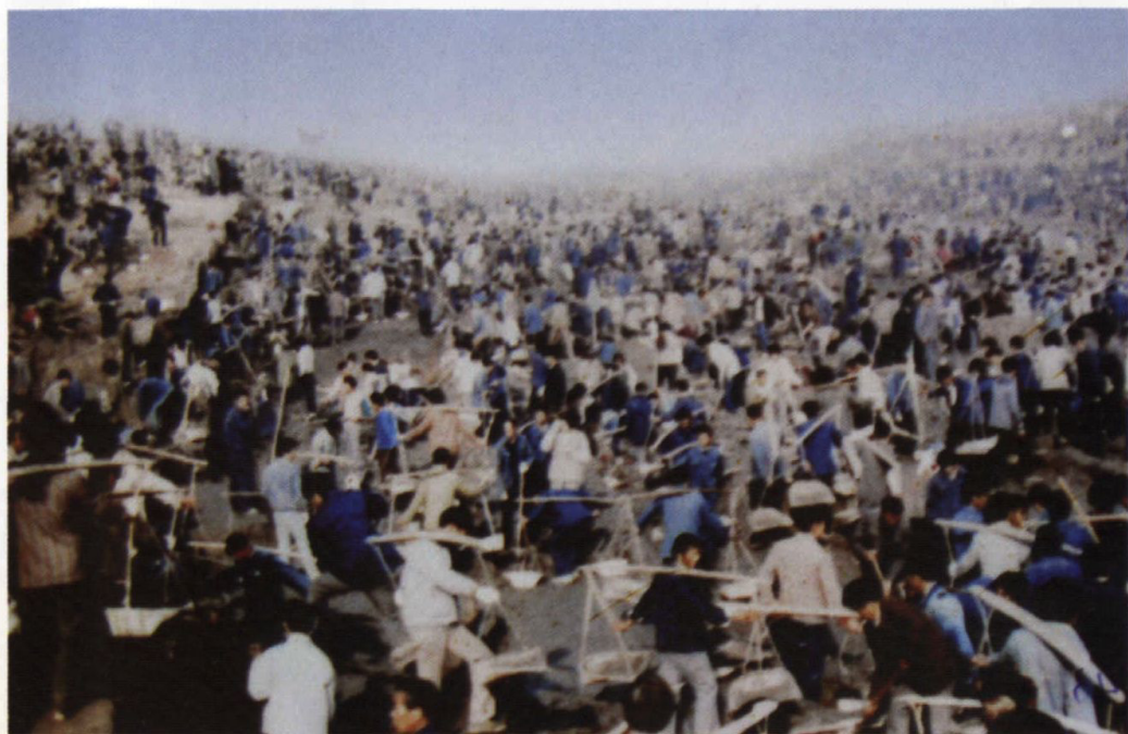
镇江陵口段断航施工
