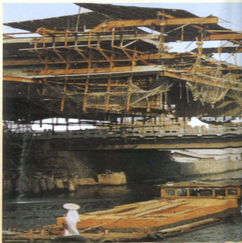
正在施工中的无锡 吴桥改建工程
