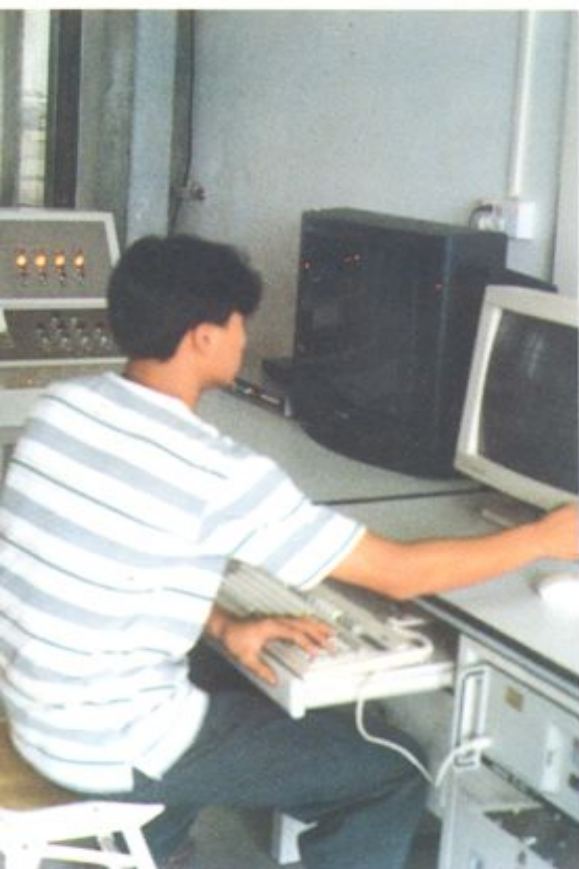
北村水闸液压启动总控室
