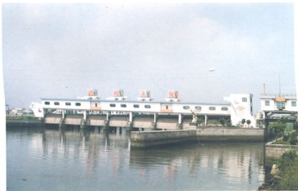
北村水闸全貌
