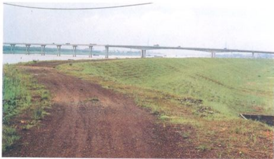
经历“94.6洪水”复堤后的佛山大堤花木洞围大函段
