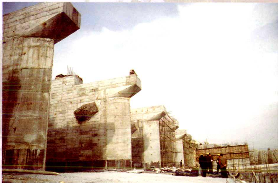
协合拉引水闸枢 纽工程施工现场 (1997年)
