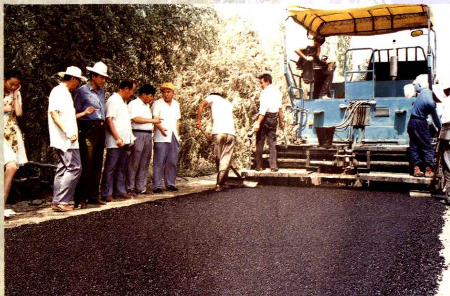
LTL45型沥青 混凝土摊铺机现场 作业
