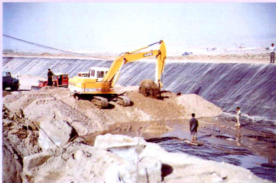
沙井子引水渠防 渗工程施工工地 (1998年)
