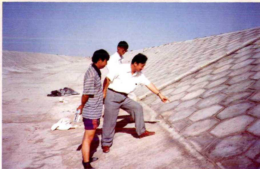
副经理司志文(右一)、 总工程师王毅(左一)检查 渠道护坡质量
