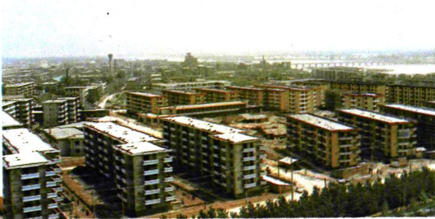
咸阳沈家住宅小区是我行八十年代贷款建成的，该小区占地286亩，建筑面积15.8万平方米。
