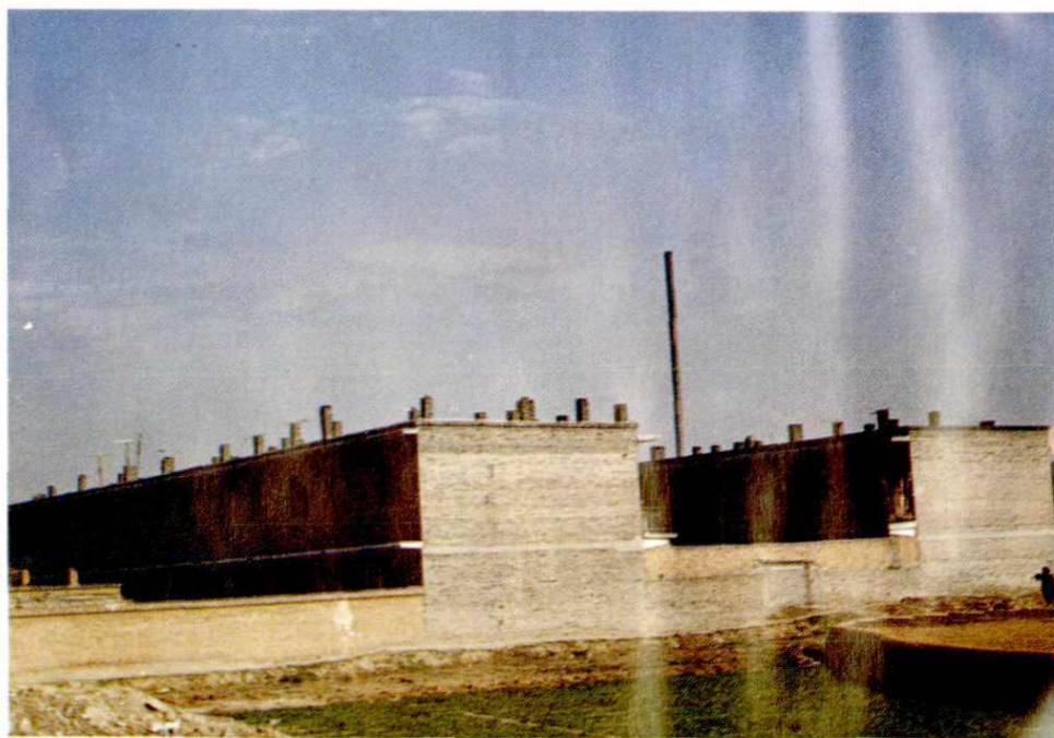
1、即将投入使用的宿舍大楼 2、1987 年修建的职工宿舍。
