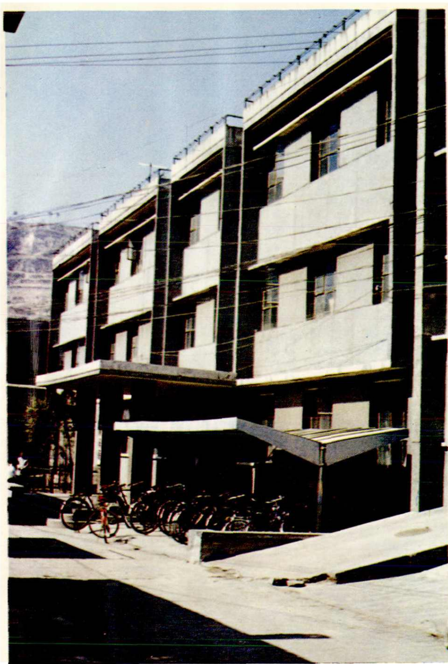
1987 年新建的税务局办公大楼
