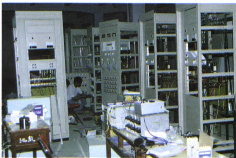
南泰自动化技术 开发公司装配车间
