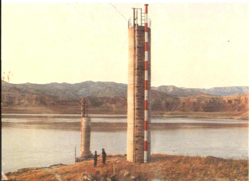
□史家滩水位站声波自记水位计 （黄河博物馆提供）
