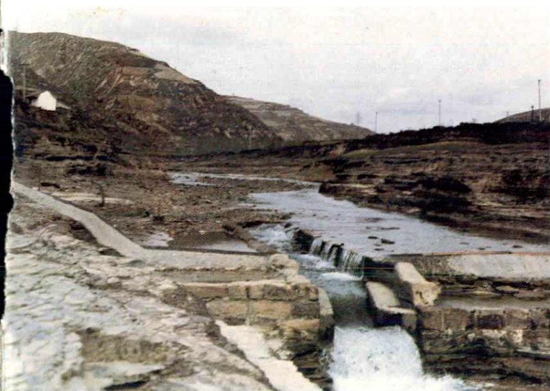
□悦乐水文站枯季测流槽 (王清叶提供)
