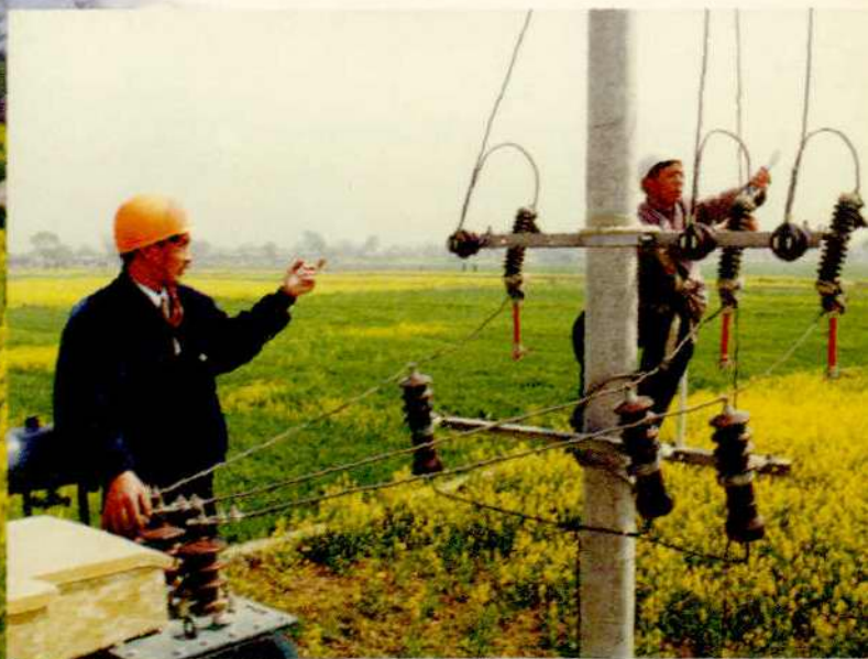
安装配电变压器
