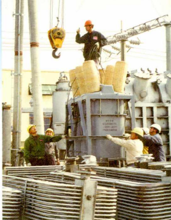
110千伏益林变电所2号主变安装现场
