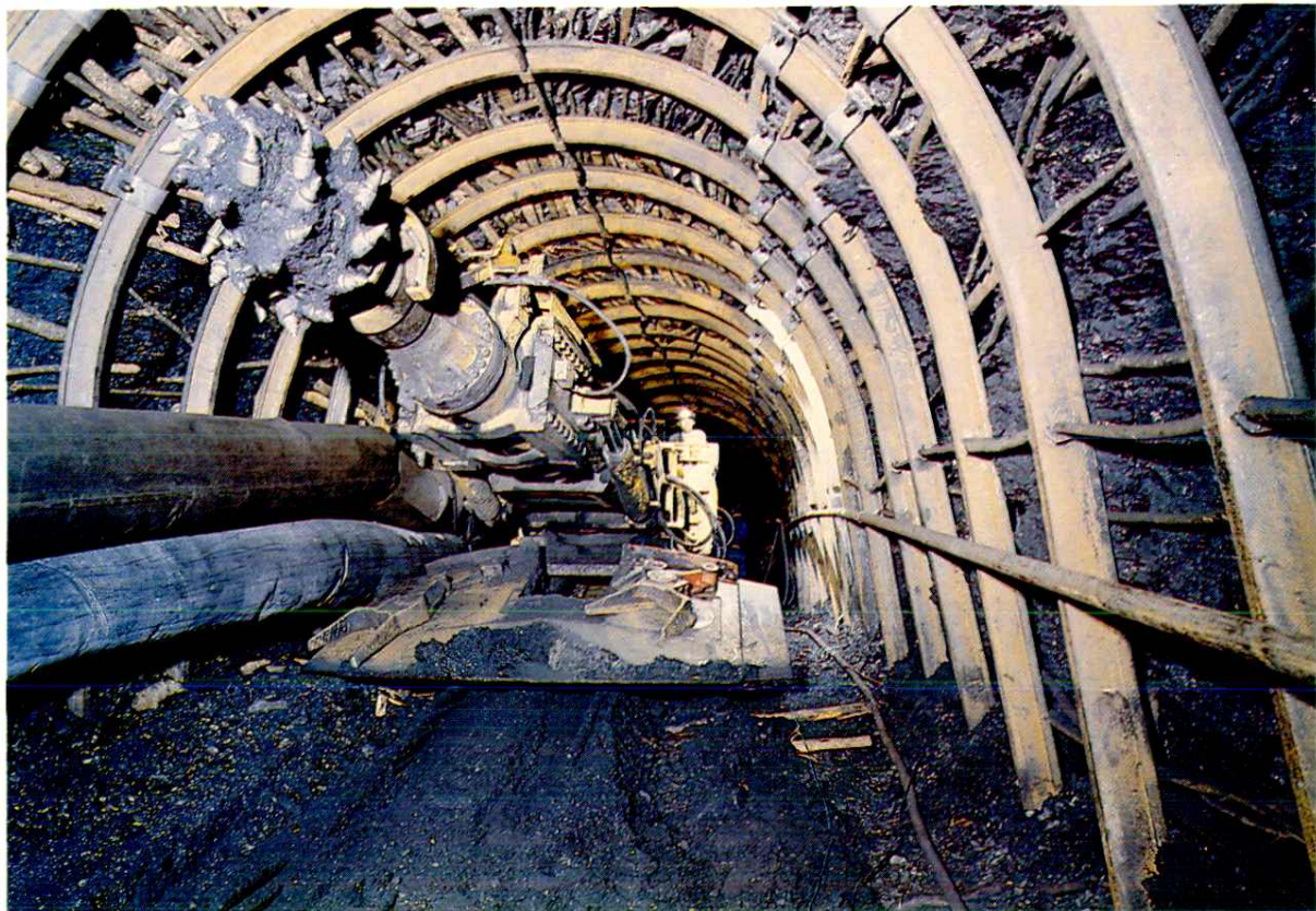
山脚树煤矿综合机械化掘进工作面
