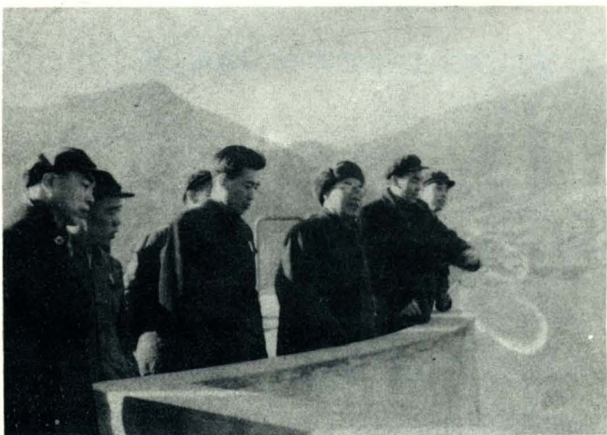
警卫朱德委员长视察新安江水力发电厂
