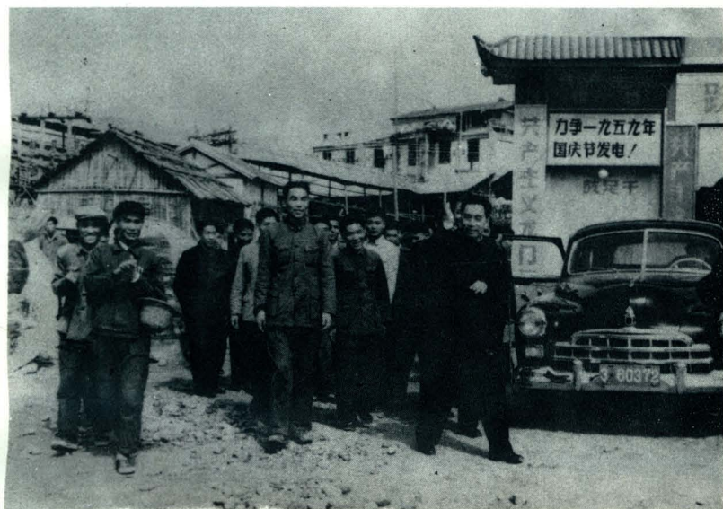
警卫周恩来总理视察新安江水电站工地
