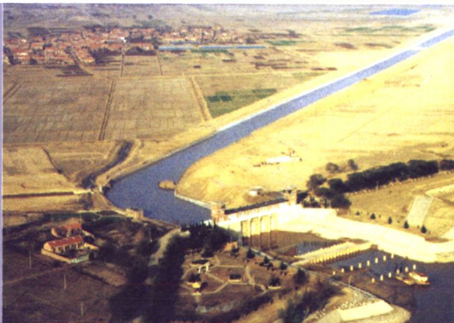
○ 王庄灌区渠首工程
