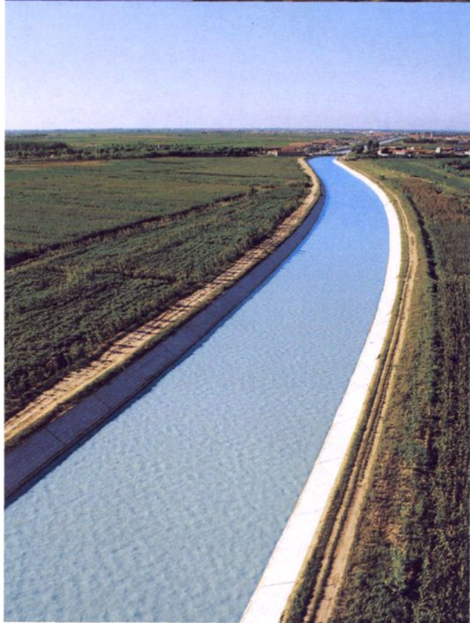
○ 干渠衬砌工程
