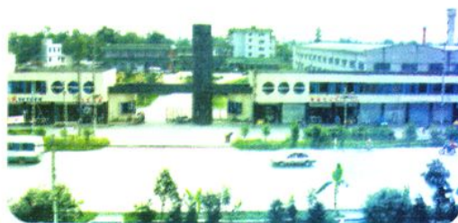
厂属丰铁公司全貌
