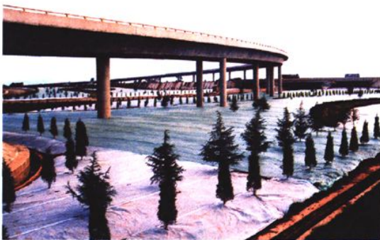
嵩明至会泽待补高速公路小铺立交桥
