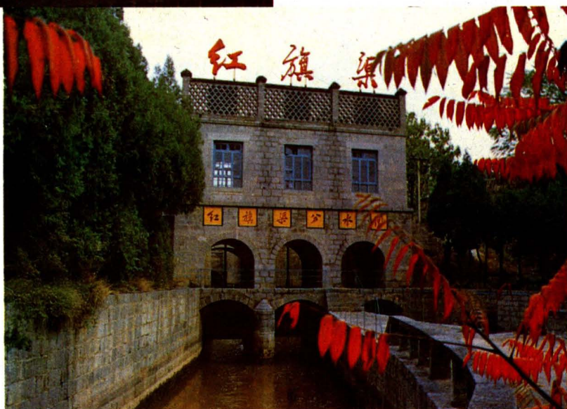
红旗渠分水闸
