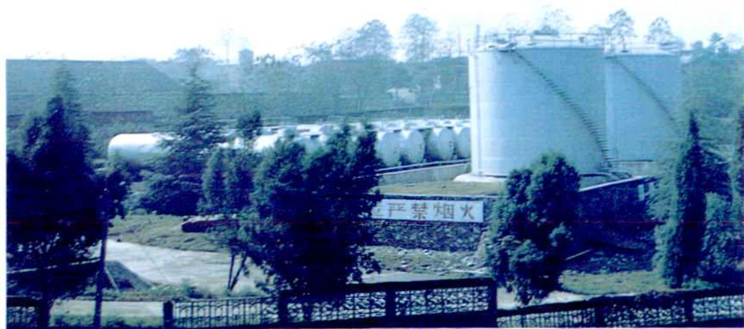
▲东安县石油公司油库储油区
