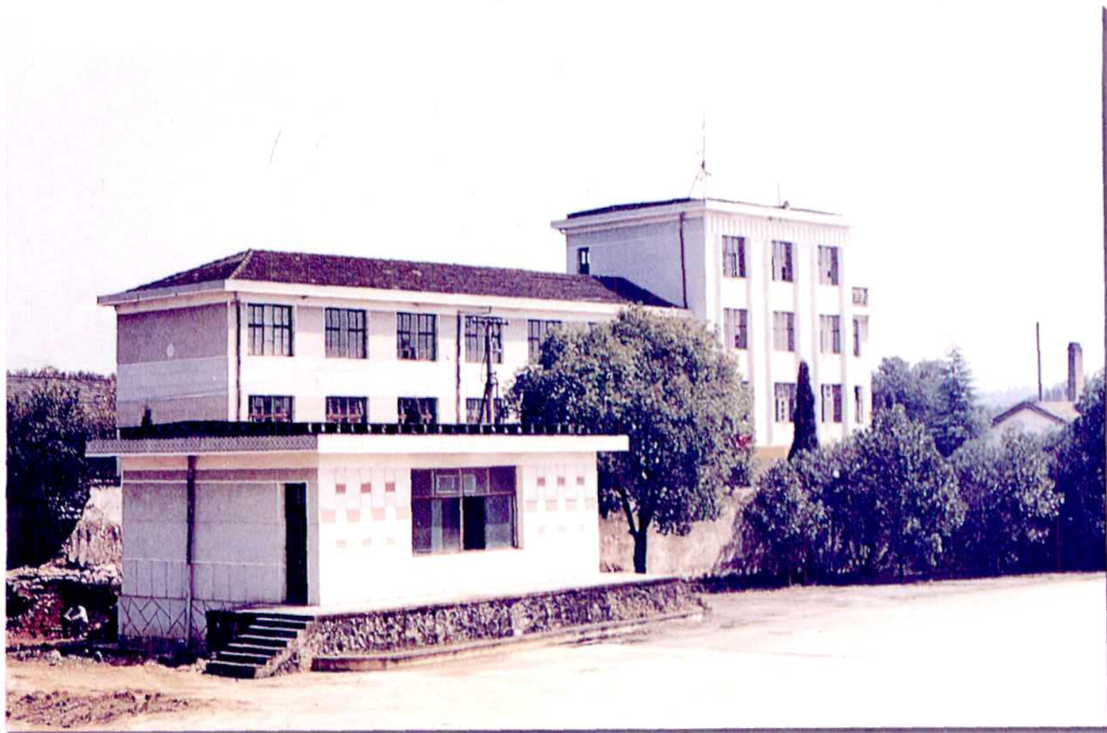
▲零陵地区石油公司办公大楼
