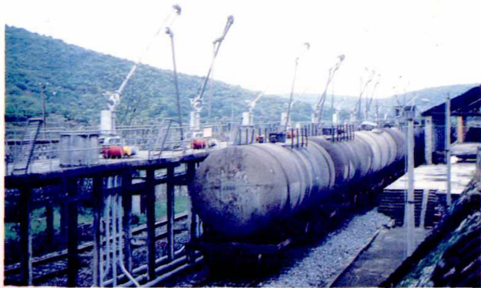
▲滩头湾油库接卸栈桥
