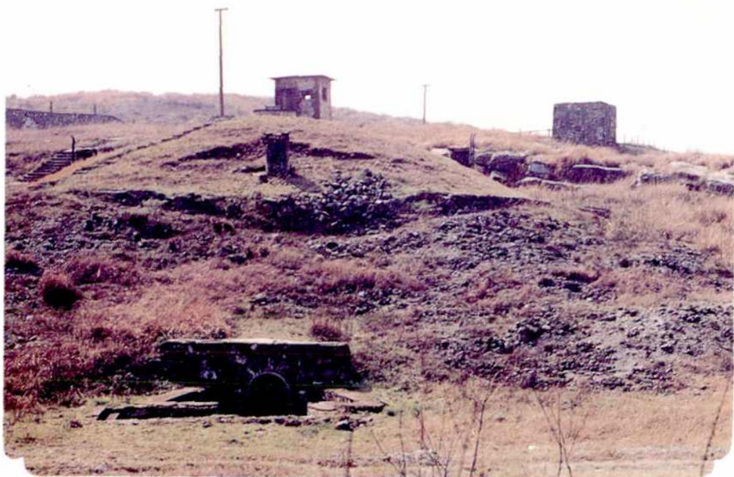
▲始建于六十年代的滩头湾油库半埋式油罐区
