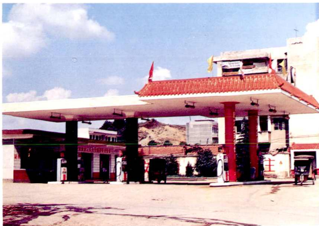
▲零陵地区石油公司第一加油站
