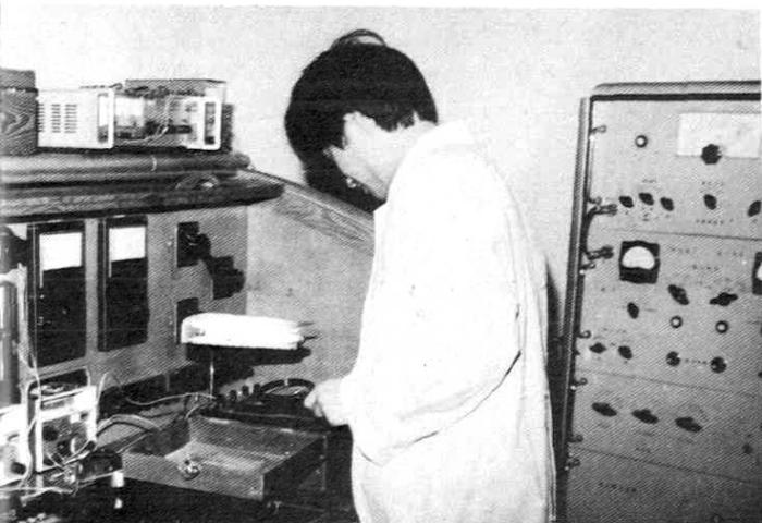
▲ 自贡市计量测试研究所检定员校验电磁仪器。
