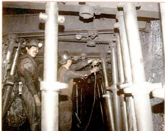
义棠煤矿悬移支架放顶煤工作面
