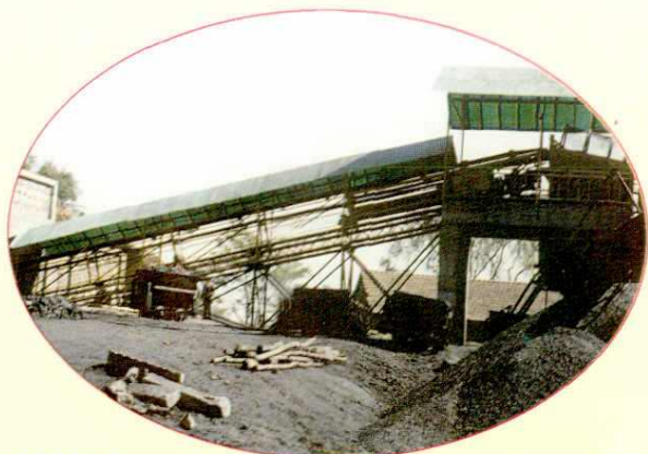
和顺南窑煤矿洪水沟矿井胶带提升及其筛分装置
