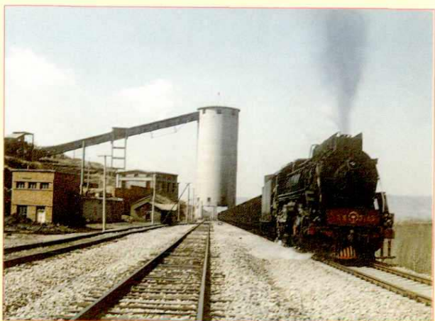
段王煤矿地面储、装、运系统
