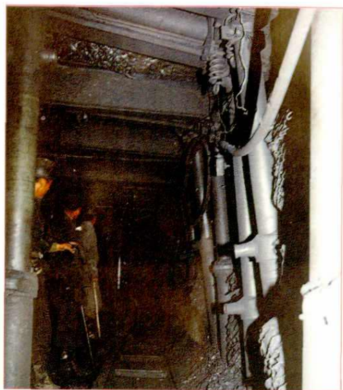
段王煤矿悬移支架放顶煤工作面
