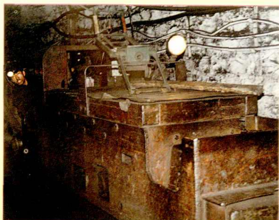
灵石煤矿井下运输大巷电机车牵引
