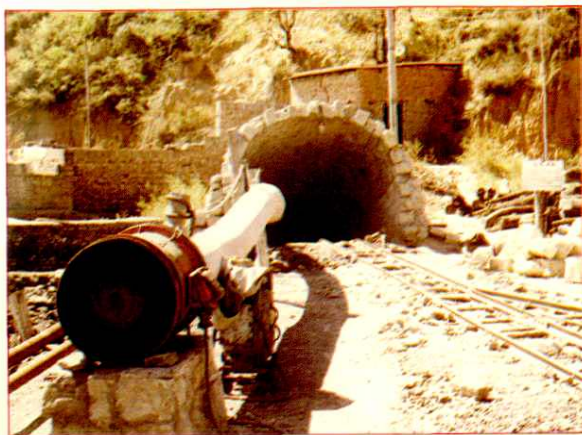
黄丹沟煤矿旧井(即日军侵华时期的军管理二十七厂)正在恢复扩建中。
