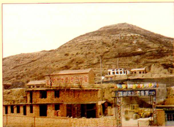
正在建设中的左权丈八煤矿
