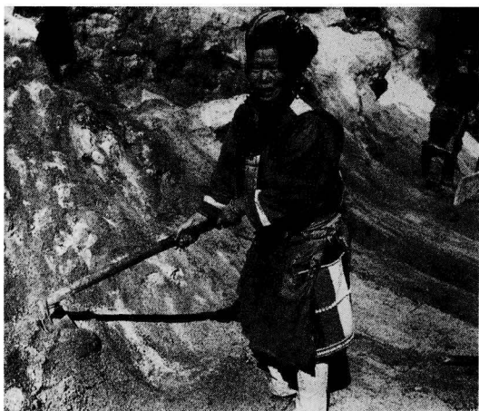
◀ 云南各少数民族积极参与了修筑滇缅公路（图为一位年迈的傣族老妈正在挖路基）
