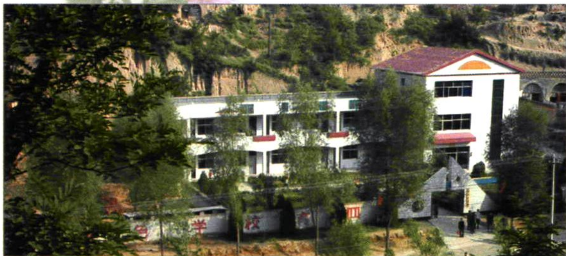
贺家坡村寄宿制小学
