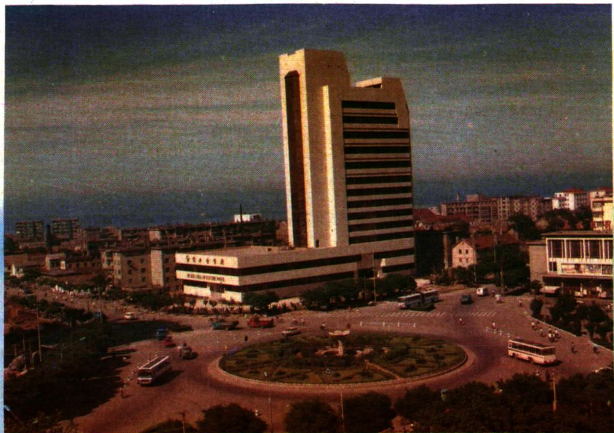
烟台电力调配中心
