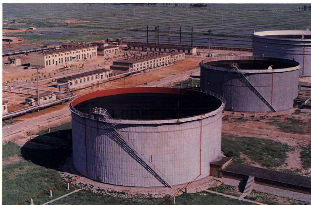
坨子里首站 4 万、2 万立方米浮顶储油罐
