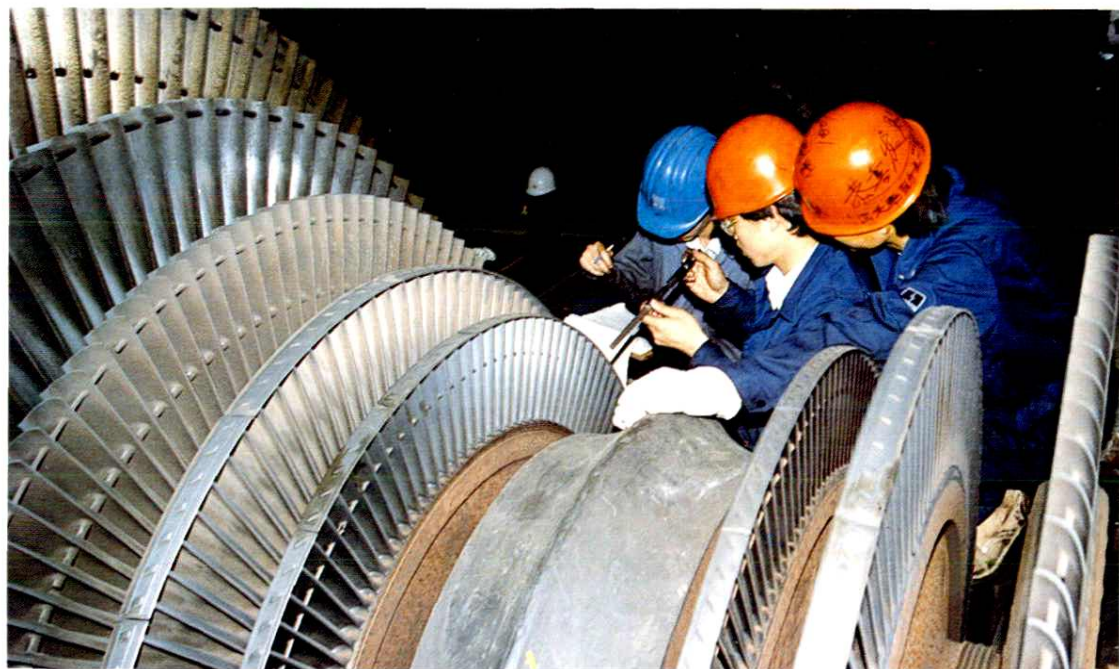
检修职工对 20 万千瓦机组进行解体检修
