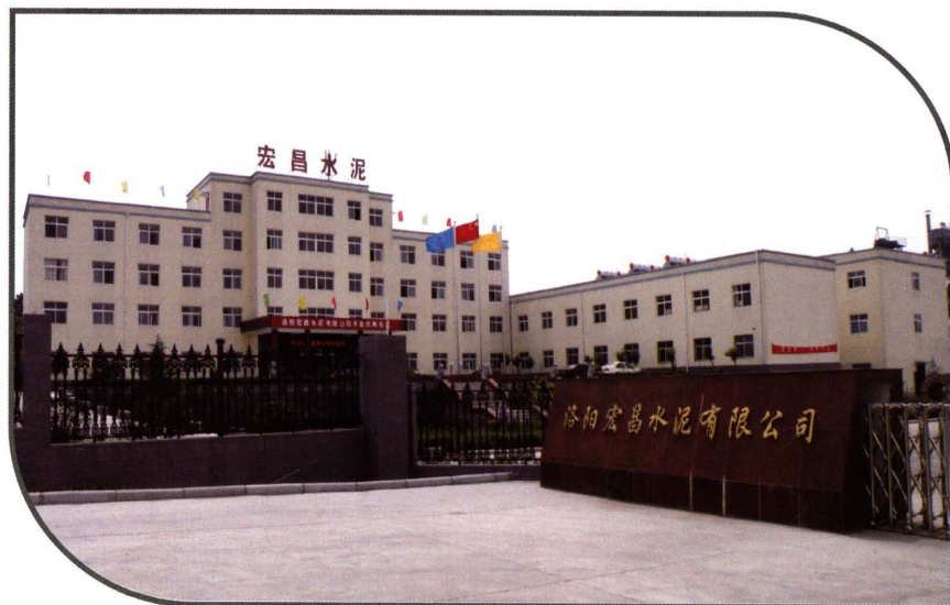
礅槽集团洛阳宏昌水泥有限公司
