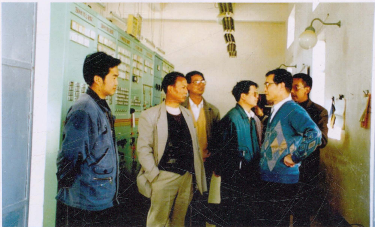
1997年1月16日，云南省电力工业局局长助理李海南到北郊变电站调研
