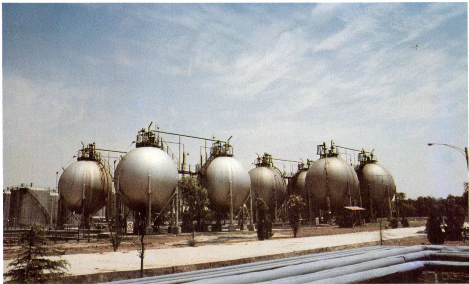
年原油加工能力为 15 万吨的油气综合处理厂一角。
