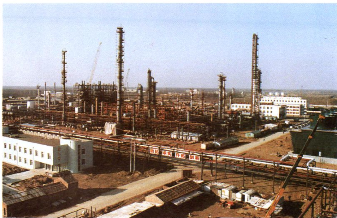
中原十四万吨乙烯建设工地
