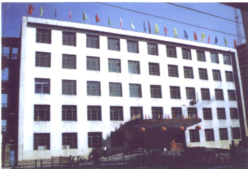
龙潭人民医院门诊医院综合楼一九八八年交付使用，总建筑面积3,100平方米。
