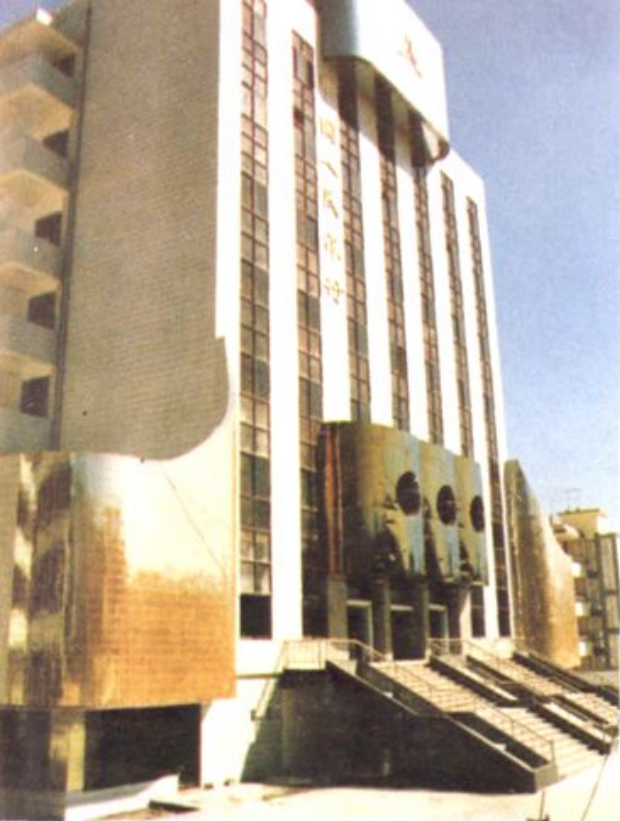
中国人民银行临沧 地区分行办公楼
