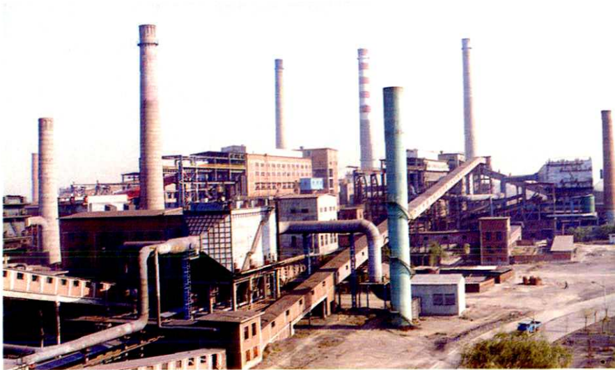
唐钢烧结厂工程
