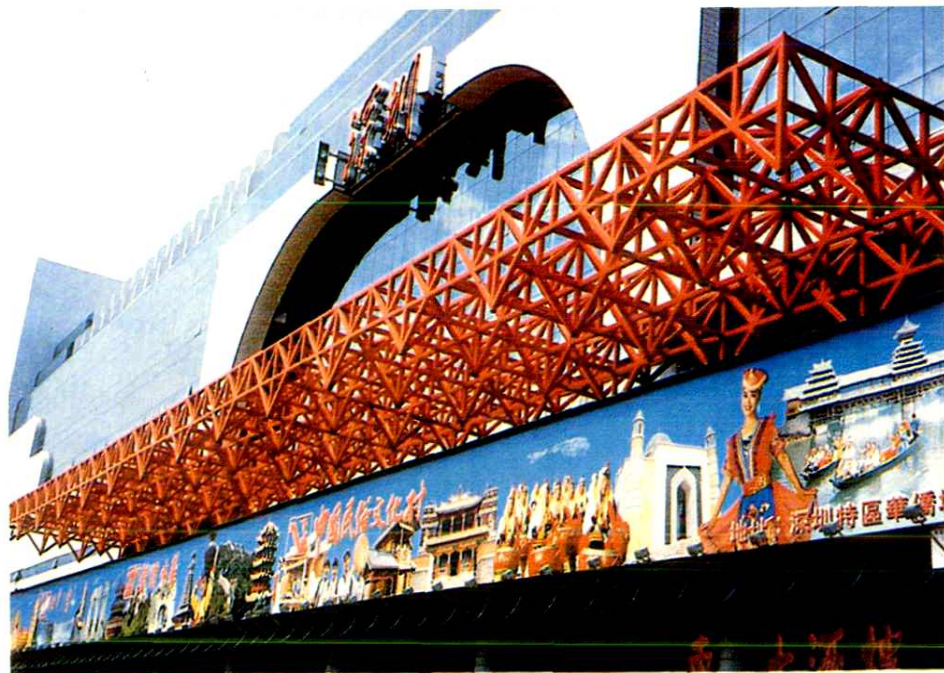
深圳火车站网架 结构制作安装工程
