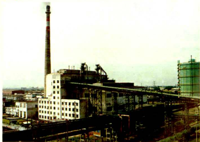
唐钢自备电站工程
