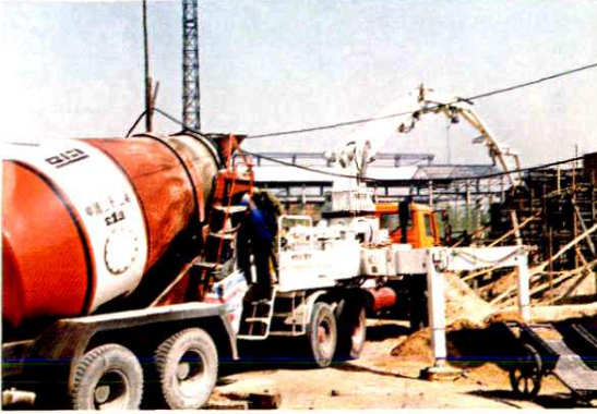
混凝土浇注泵车
