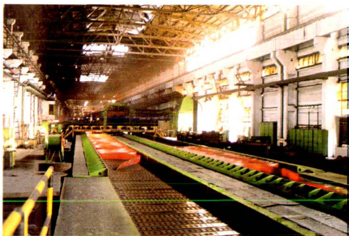
莱钢 500 毫米热带轧 钢工程
