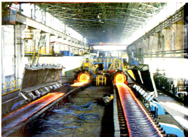
青钢高速线材工程
