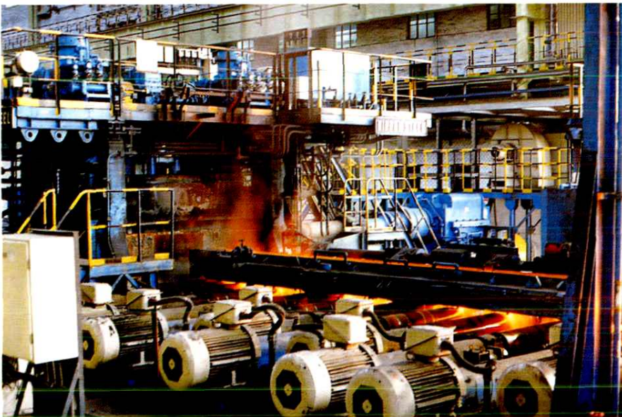
莱钢中型型钢工程
