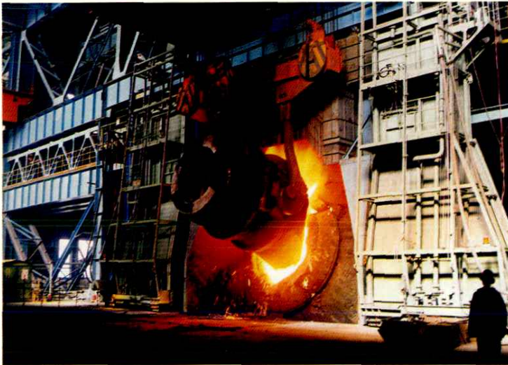
唐钢第一 炼钢厂 160 吨 转炉工程
