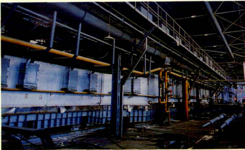
秦皇岛耀华浮法玻璃厂工程
