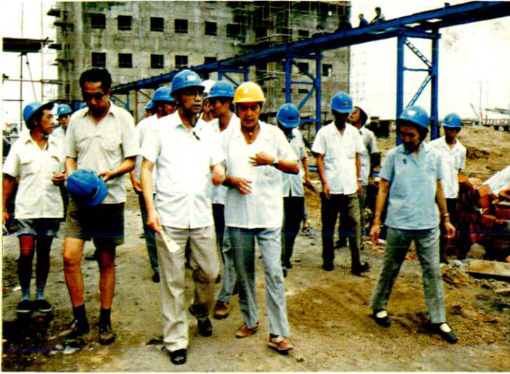
原冶金工业部副部长王汝林（前右）视察二十二冶唐钢炼焦制气厂工程
