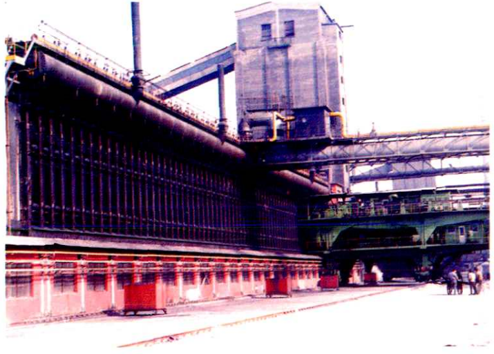
北京焦化厂 4号焦炉工程
