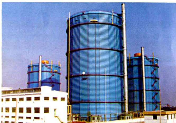
承钢10万立方 米煤气柜工程
