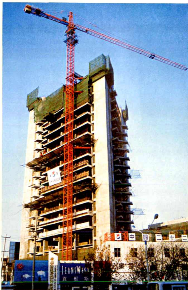
唐山新华大厦工程
