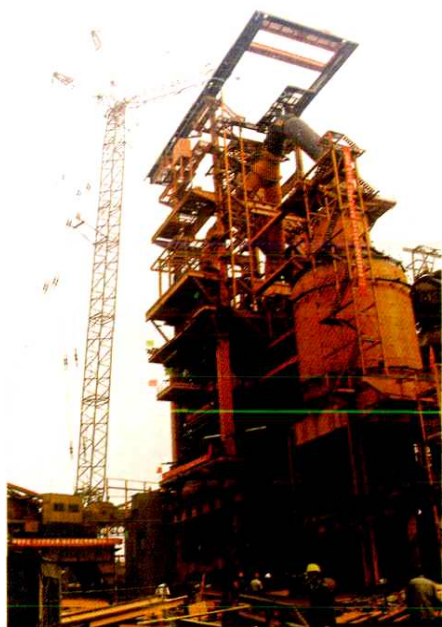
邯钢 2000 立 方米高炉工程
