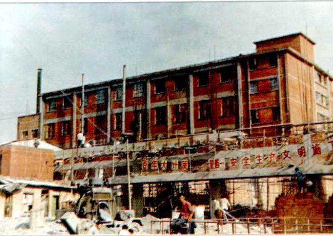
1982年竣工的旬阳烟厂雪茄型卷烟生产大楼
