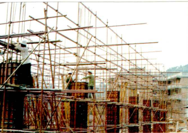
旬阳烟厂三期技改工程主体厂房施工现场
