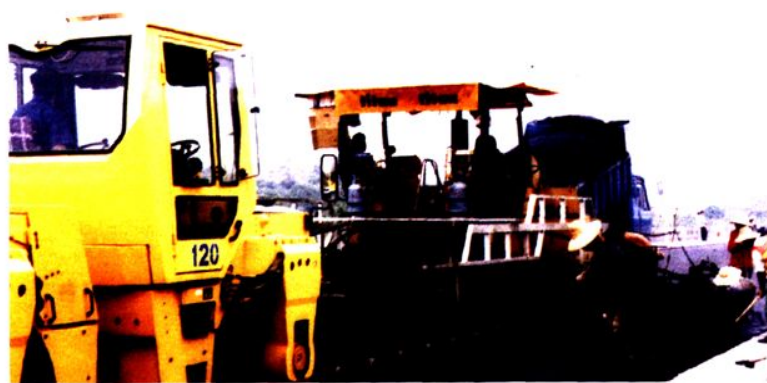
▲ 路面摊铺作业
