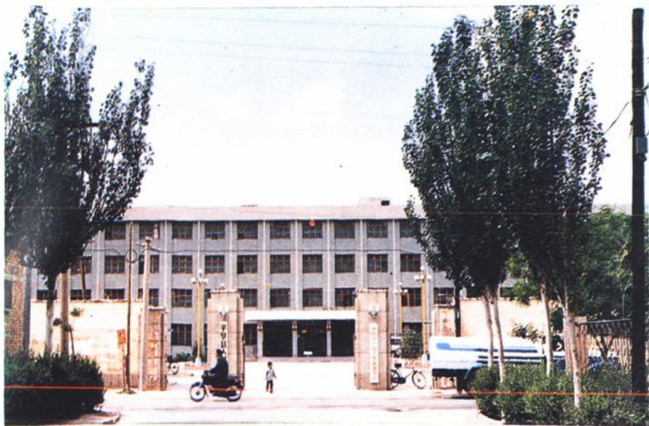
平罗县党政大楼
