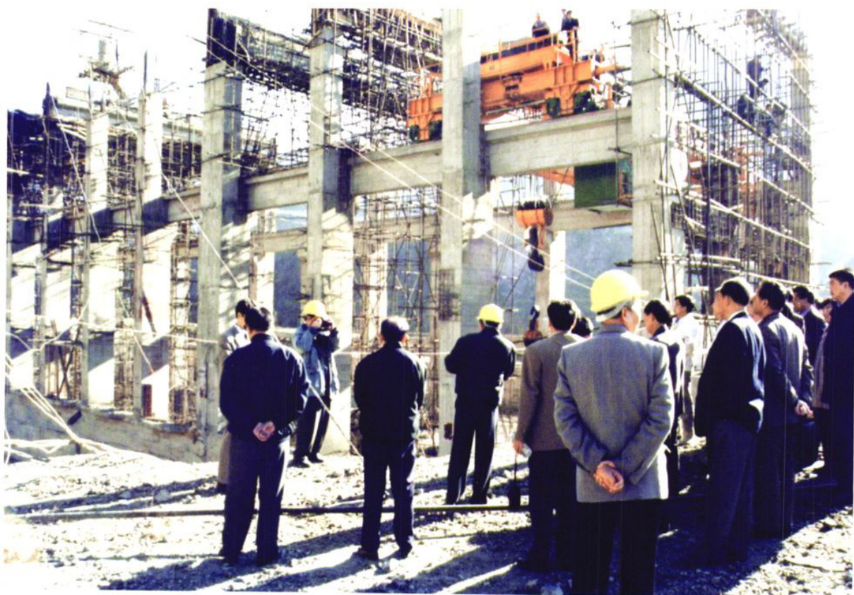
州政协委员视察大桥水库电站建设工程
