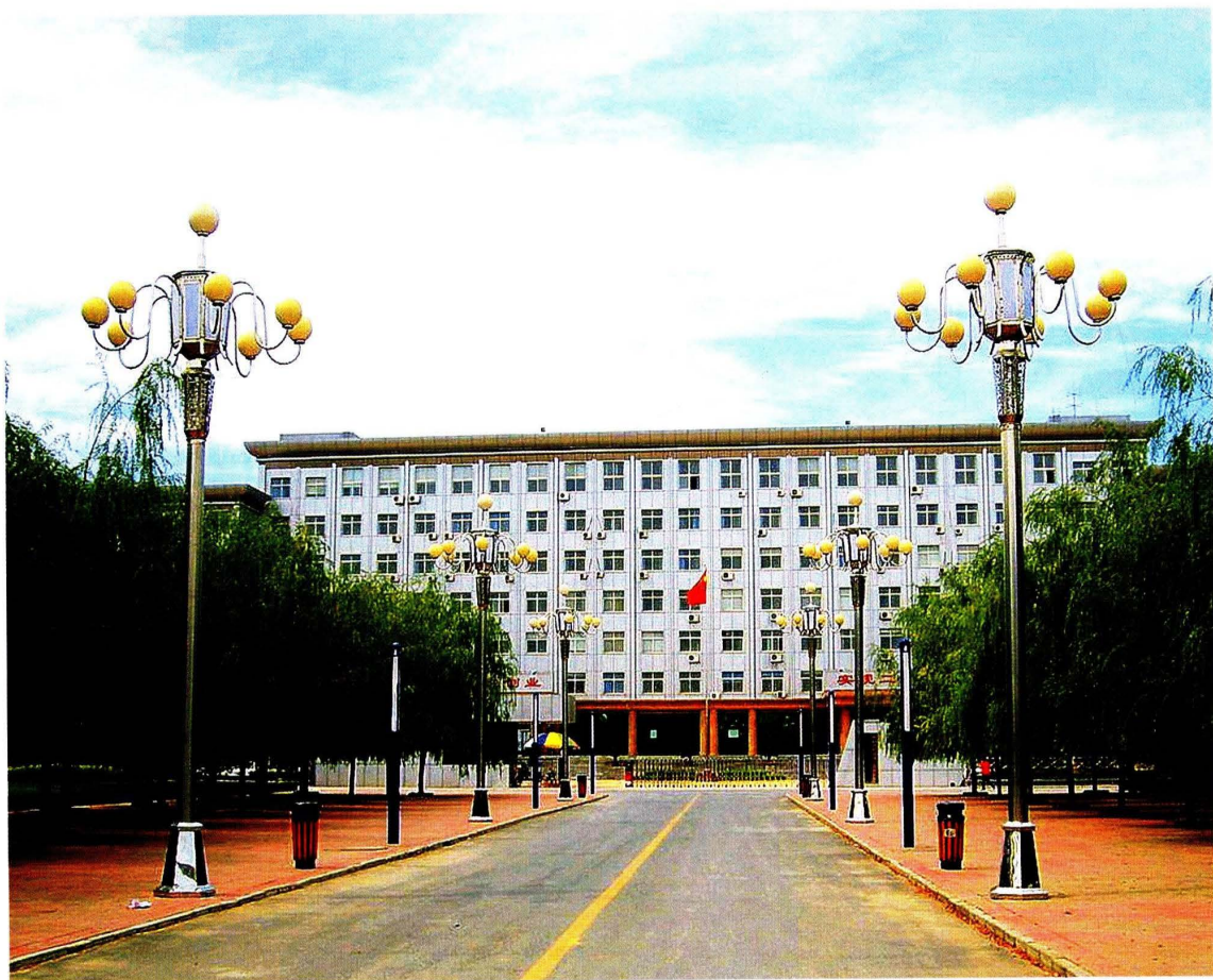
◎肃宁县委、县政府办公楼
