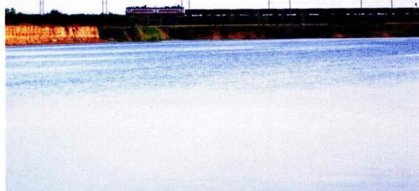
◎ 付家佐平原水库
