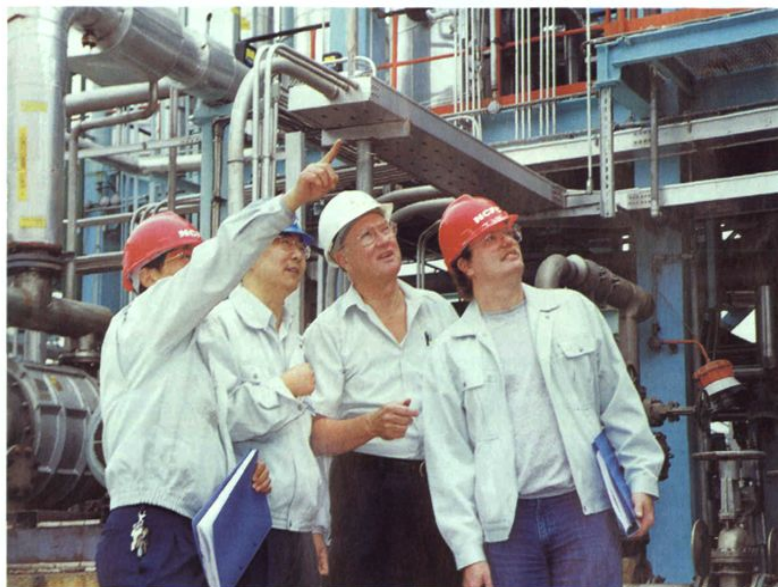
现场技术交流，图为南纤公司三期工程醋酸回收建设现场。
