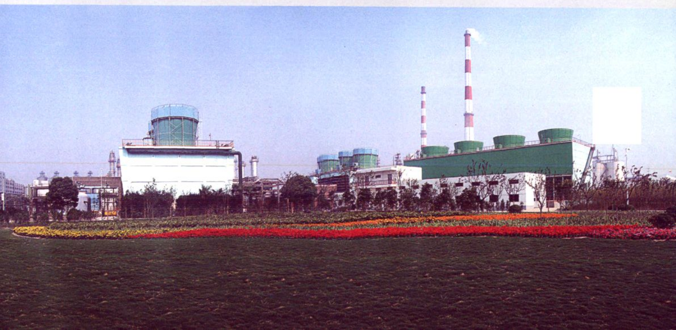
南纤公司厂区(局部)
