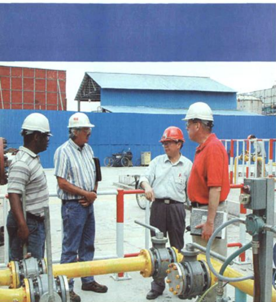
现场技术交流，图为南纤公司二期工程醋酸回收建设现场。
