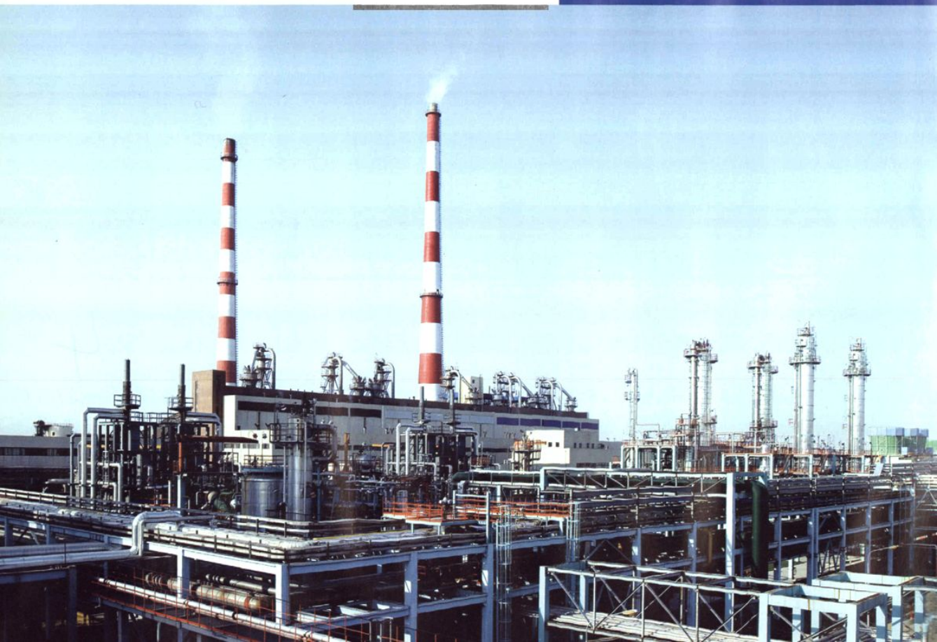
南纤公司热电站
