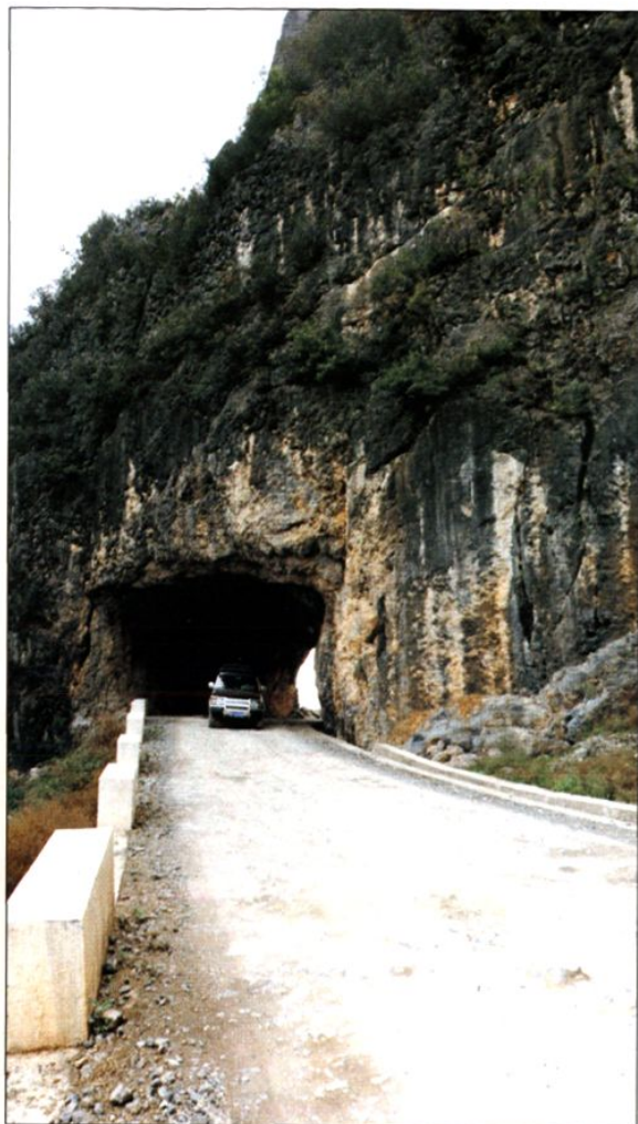
南(江)汉(中)公路隧道
