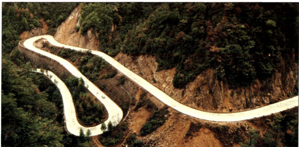
战备出川公路——南(江)汉(中)公路
