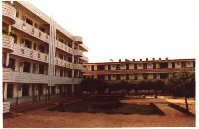
丙麻中学教学楼
