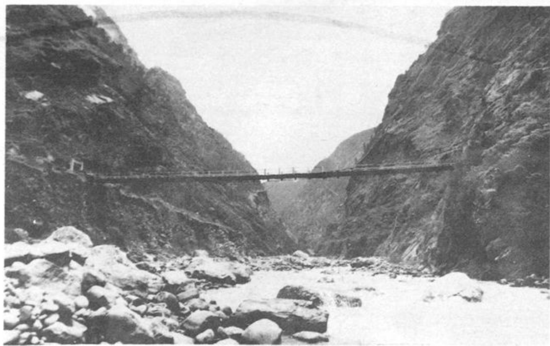
图版二十四 热索桥现状
