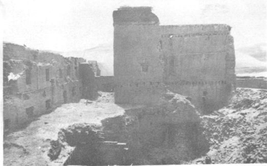
图版八 曲的寺残存墙体
