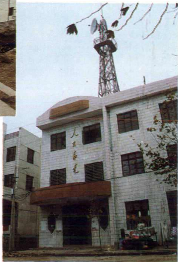
石门街镇程控微波塔
