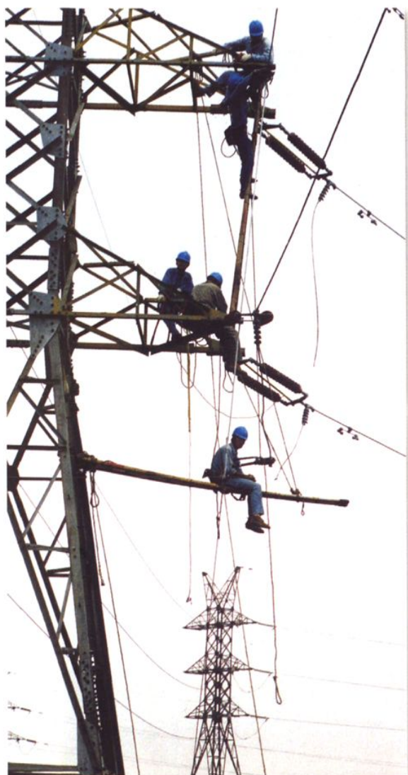
8 线路施工现场
