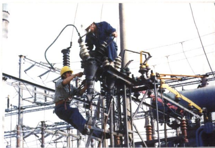
⑥ 10 千伏电缆故障抢修现场
