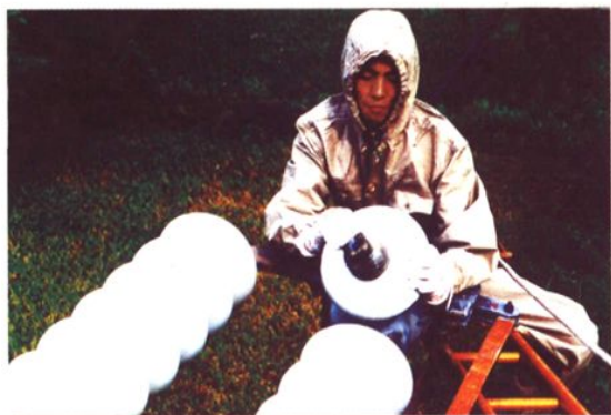
9 220 千伏线路等电位带电更换绝缘体
