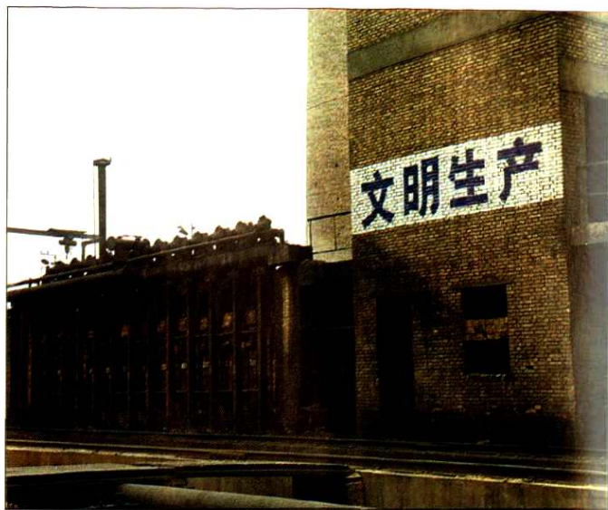
公司焦化厂一角
