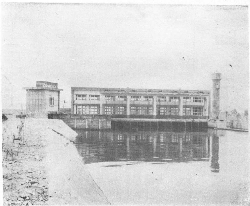
三合堰电站厂房
