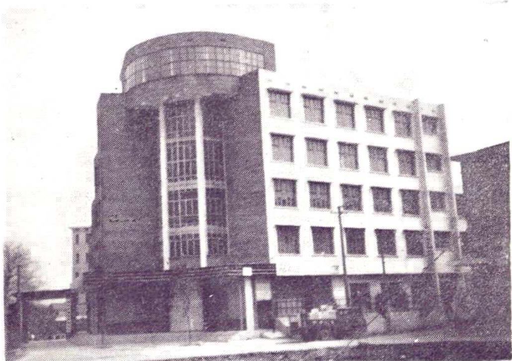
湘潭县农业局、农业技术推广中心办公大楼
