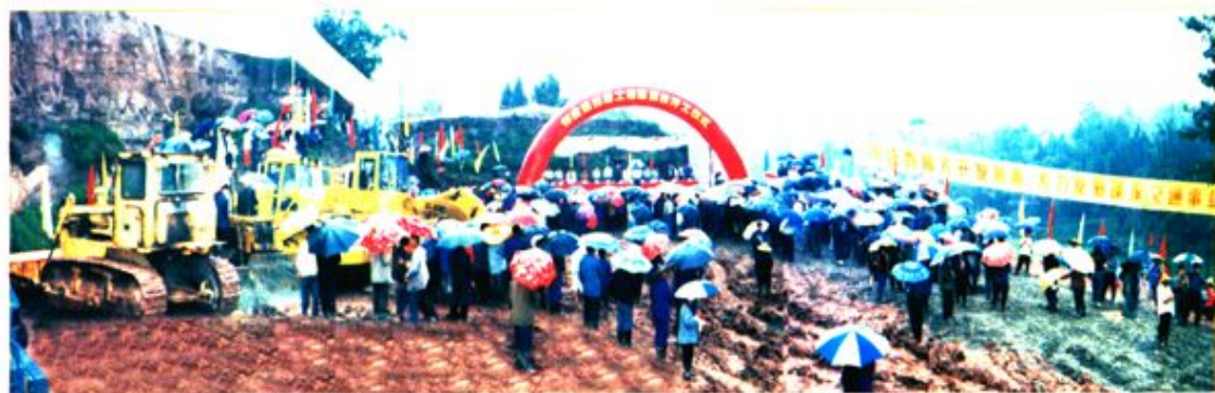
邻遂路改建工程蓬溪段开工仪式
