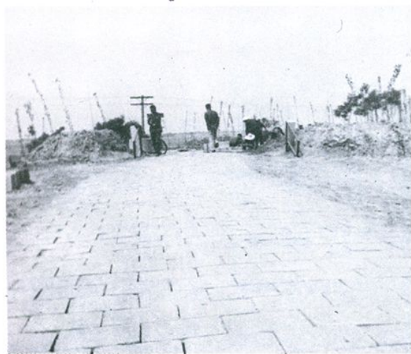
竣工后的堤顶硬化路面 胡锡淑 摄
