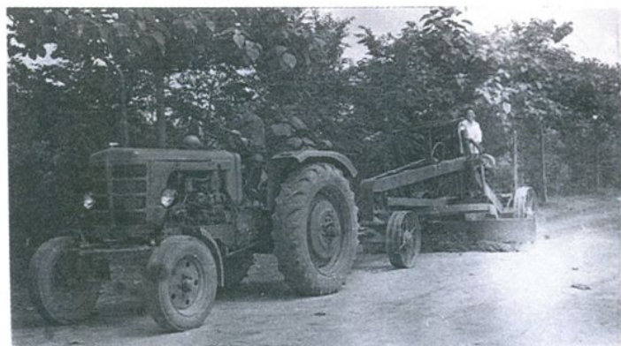
用刮板机刮平堤顶 徐尧虎 摄
