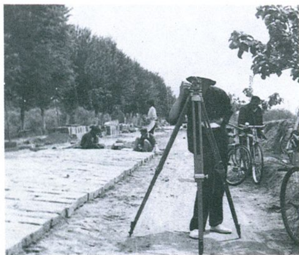
铺设堤顶硬化路面 胡锡淑 摄
