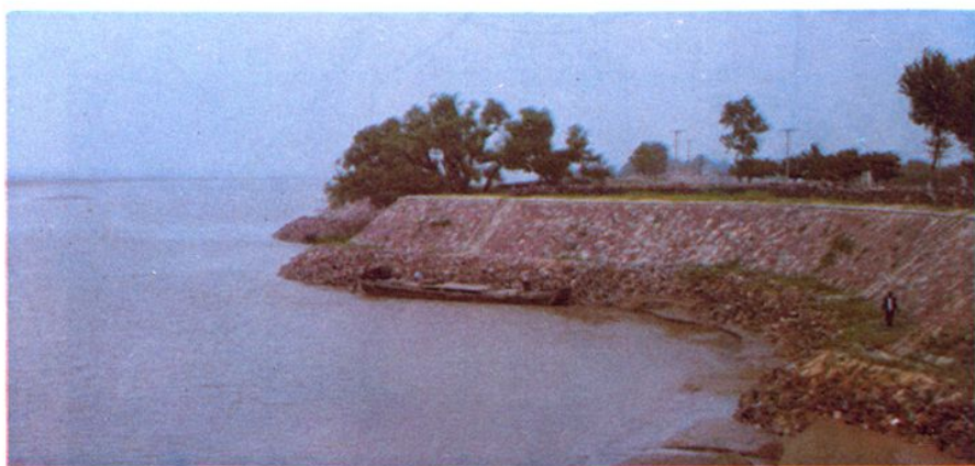
黑岗口险工盖坝 马刚 摄
