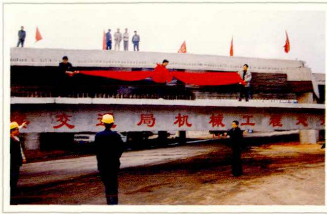
吕梁行署交通局机械工程处在夏汾高速建设立交桥
