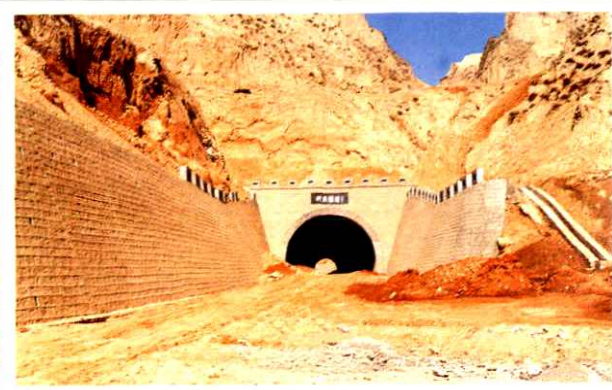
隧道全长 320 米 扶贫路山底沟
