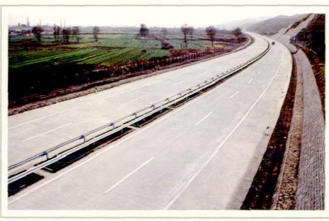
2000年10月竣工通车的吕梁地区第一条高速公路夏(家营)一汾(阳)高速公路文水段
