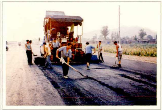
施工中的县道柳(杜)一开(栅)线开栅段一级公路
