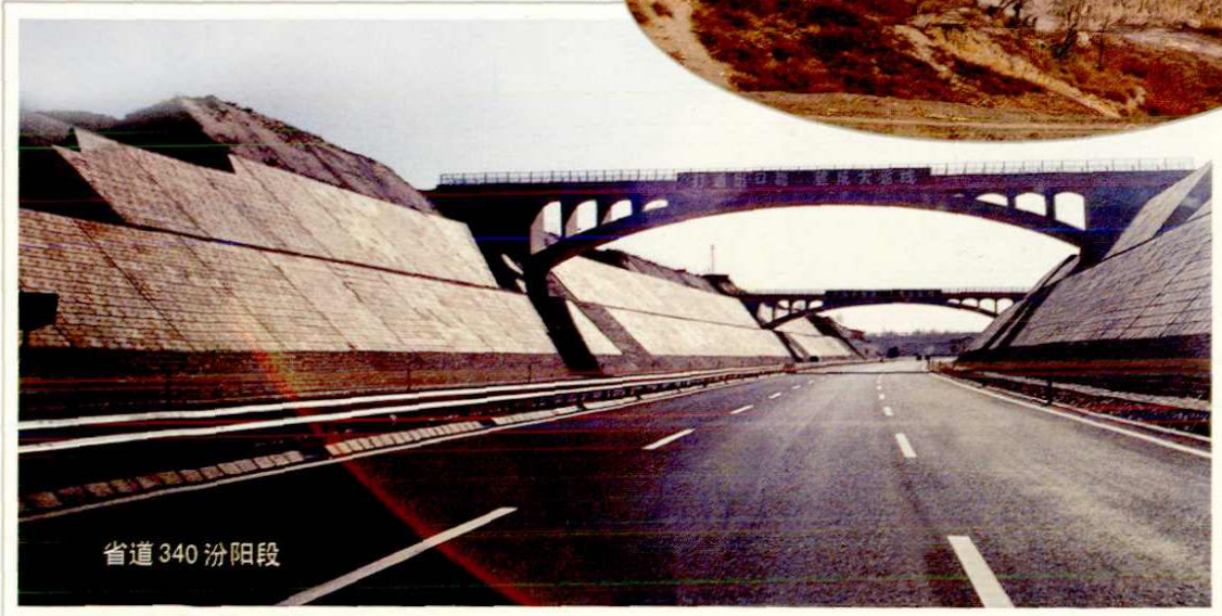
▲ 省道祁(县)方(山)线汾河刘胡兰大桥于2008年6月竣工通车
