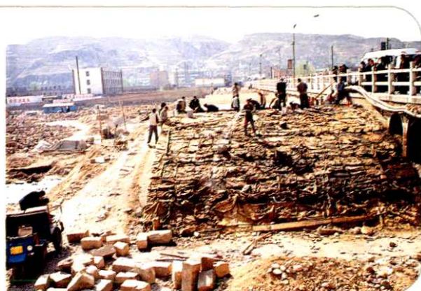
临县东郊大桥加宽施工现场
