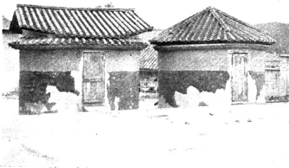
九溪粮管所土园仓库一角
