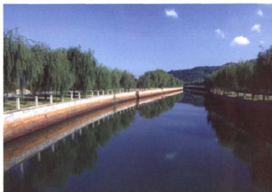
四明湖水库总渠
