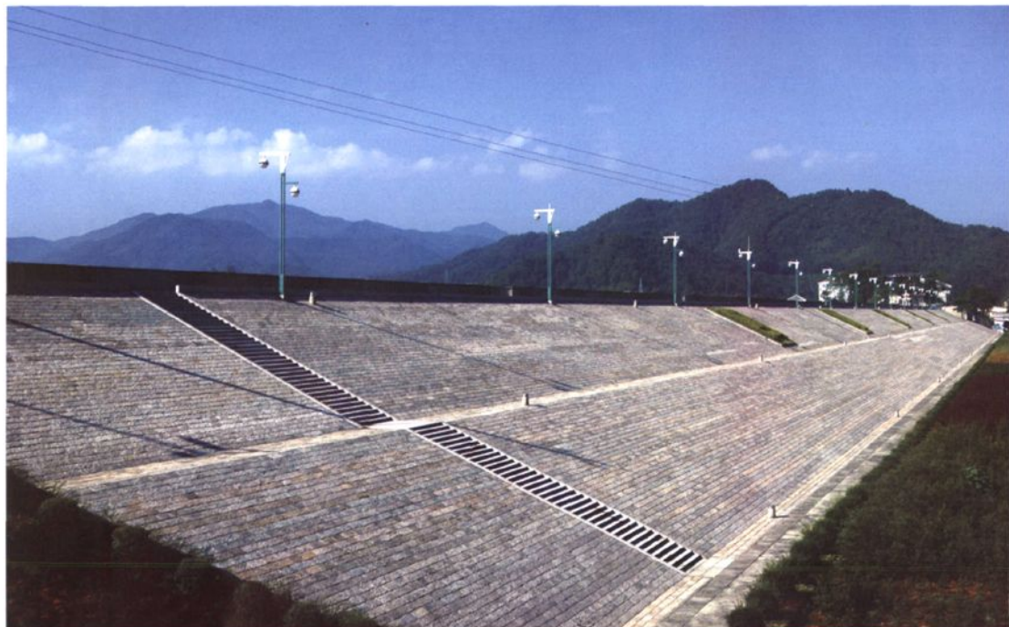
拦河大坝（背水坡）
