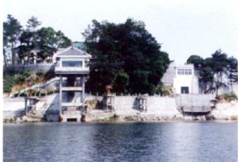
输水隧洞管理房
