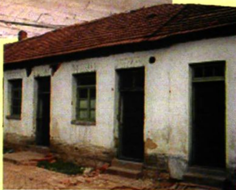
新病房楼开工前拆除的旧医疗用房， 上为原病房楼，右为原防疫科
