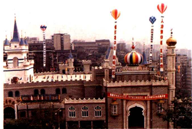
九龙建筑建材工程总公司修建的欢乐大世界
