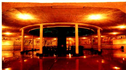
杨家坪地下人行道
